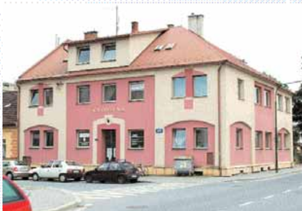
Původní budova Masarykovy knihovny ve Vsetíně
