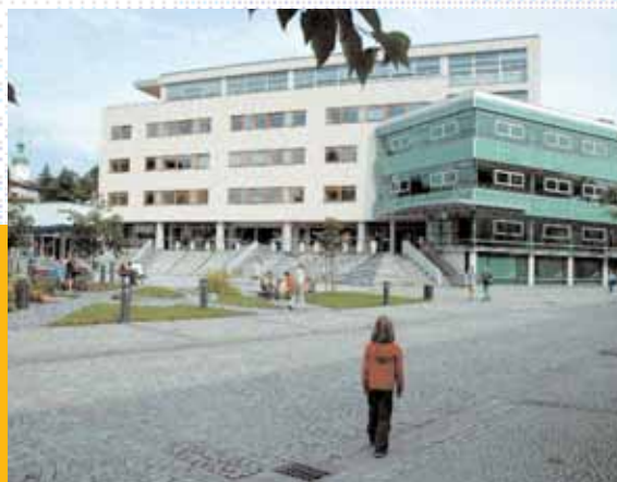
Zrekonstruovaná budova na náměstí, ve které bude nová knihovna
